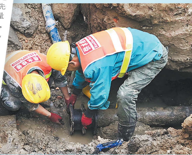
及时修复受损供水管道。
