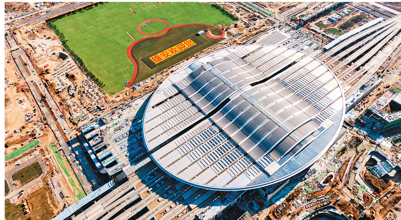
12月18日,航拍京雄城际铁路雄安站。
