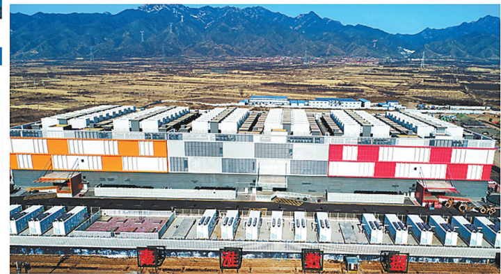
总部位于张家口怀来县东花园开发区的秦淮数据产业基地外景。
