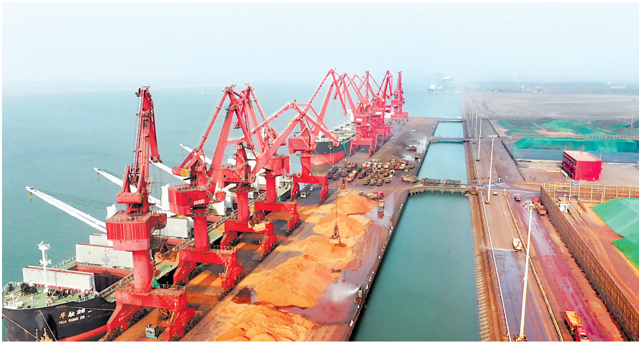
12月21日,在河钢物流黄骅港公司码头,印尼籍“华融26”轮和巴拿马籍“格莱斯顿”轮正在进行外贸矿石卸船作业。在黄骅港转型升级中,该公司码头今年跨入了千万吨级国际化码头行列。河北日报通讯员 戴玮序摄
