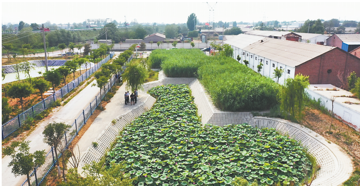
▲晋州市龙头村采用功能型精准湿地工艺建成的污水处理站。该处理站集功能型湿地、生态塘、雨水收纳池等于一体,具有湿地休闲景观功能。(河北日报资料片) 河北日报通讯员 邵运庆摄
