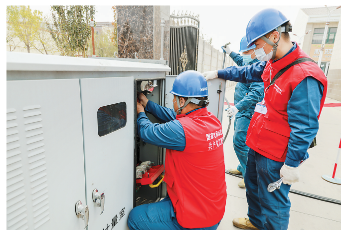
近日,国网深泽县供电公司会同石家庄思凯电力建设有限公司深泽分公司,结合该县“布艺小镇”小堡村用电需求,开展电力设施抢修作业,以保障辖区内电商客户用电无忧。 河北日报记者 董昌摄
