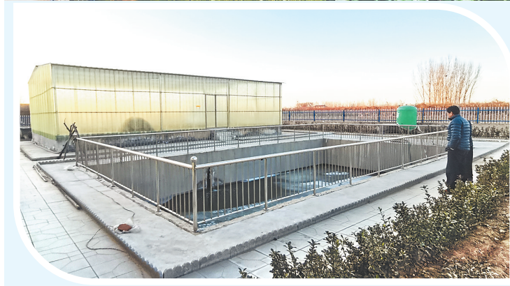
▲晋州市龙头村采用功能型精准湿地工艺建成的污水处理站。该处理站集功能型湿地、生态塘、雨水收纳池等于一体,具有湿地休闲景观功能。(河北日报资料片) 河北日报通讯员 邵运庆摄
