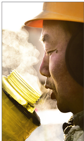
上图:2020年12月29日,雄安新区容东片区B1组团安置房项目施工现场,工人喝水驱寒。
