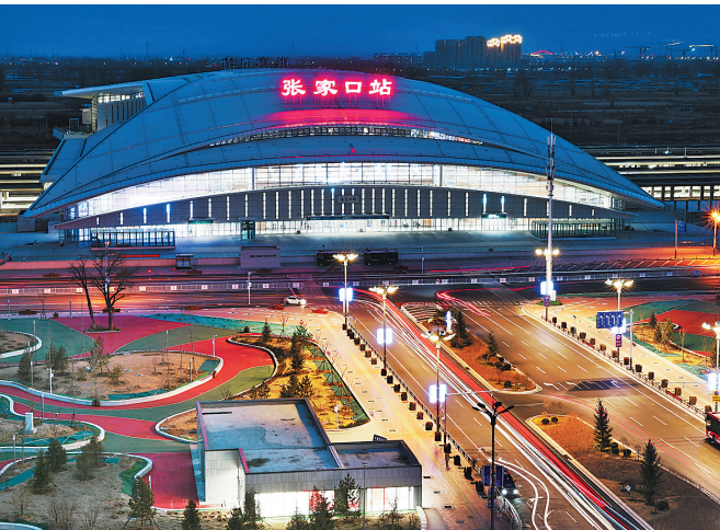
日前,夜幕下的张家口站流光溢彩。自该站于京张高铁开通后正式投入使用以来,张家口经济开发区通过实施道路工程、绿化工程、亮化工程等一系列配套设施建设,使这里逐步成为环境优美、交通畅通、夜色迷人的城市新地标。
