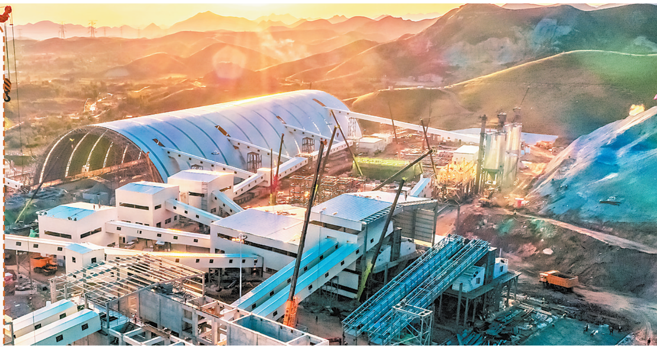
南水北调中线雄安调蓄库及弃渣综合利用工程建设现场。
