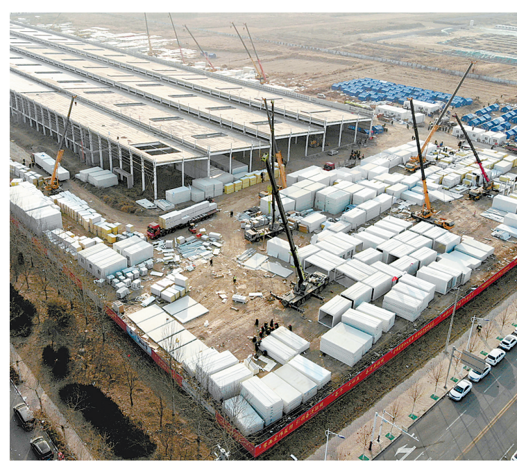
1月19日拍摄的位于南宫经济开发区的隔离场所项目建设现场。连日来，在位于南宫经济开发区的隔离场所项目建设现场，施工人员不畏严寒，昼夜施工抢工期。据了解，南宫市在第一期隔离房已经交付的基础上，继续推进二期集中隔离房建设。 新华社发
