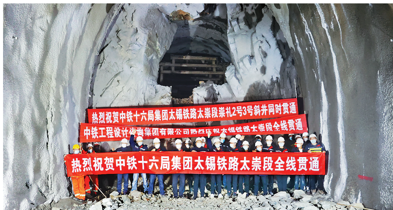
图为隧道贯通现场。河北日报通讯员 逯占友摄
