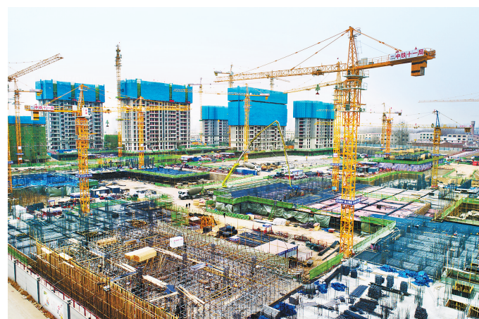
眼正是隆冬时节,但在保定深圳园项目施工现场,各项工作仍在紧张有序地展开,到处是一片抢工期、抓建设的繁忙景象。河北日报通讯员 云娟 高欣悦摄
