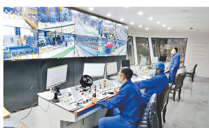
河钢石钢新区轧钢厂生产人员正通过显示屏跟踪各条产线生产情况。
