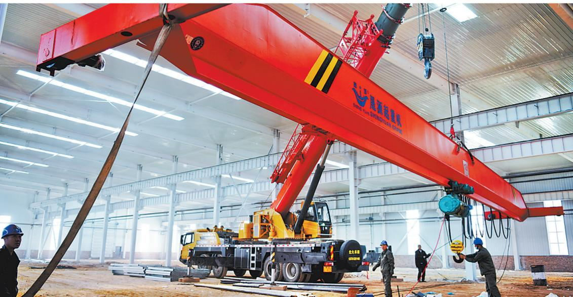
3月10日,张家口市宣化区宏达冶金设备制造有限公司新建的雪场用脱挂索道生产线正在进行天车安装施工。近年来,宣化区抢抓京津冀协同发展和北京冬奥会筹办等机遇,发挥装备制造基础优势,积极同京津科研院所合作,建起了占地3000亩的冰雪产业园,冰雪装备制造企业发展到10家,研发生产的雪场用脱挂索道上、下站设备、造雪机支架、压雪机等装备销往10多个国家和地区。
