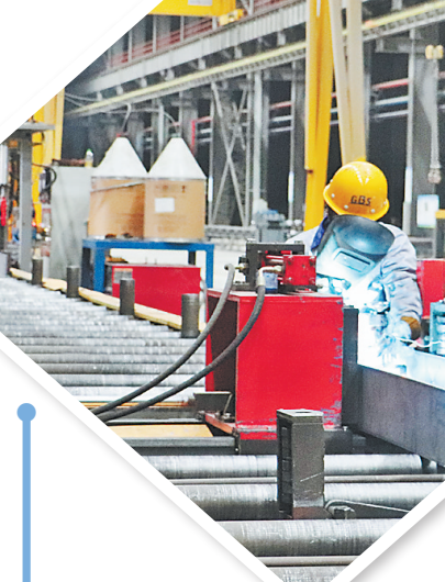
日前,秦皇岛精工筑集成科技有限公司工人在紧张地作业。抚宁区以精工筑集成装配式建筑产业基地项目为龙头,努力形成优势互补、门类齐全的绿色建材产业链条,打造国家级装配式建筑产业示范基地。 抚宁区委宣传部供图
