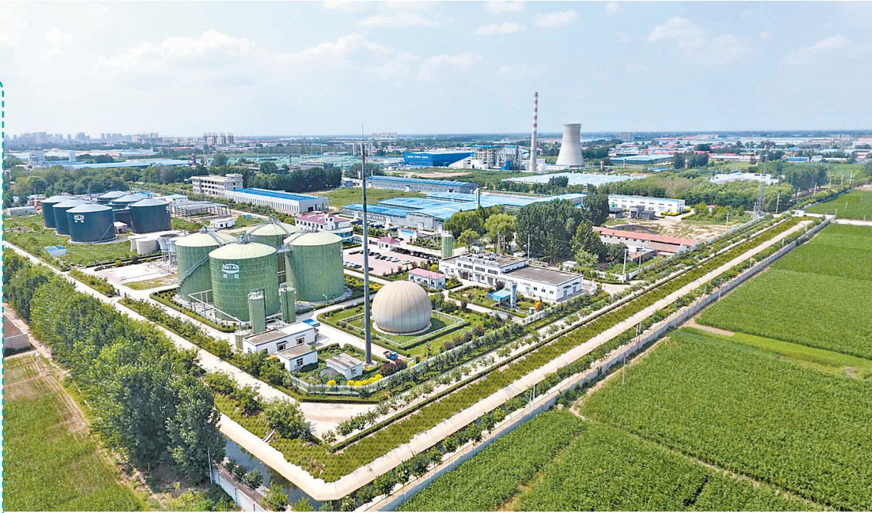
位于安平县的河北安生生物能源科技股份有限公司。在这里,生猪粪便经过厌氧发酵后产生沼气、发电等,实现循环利用。
