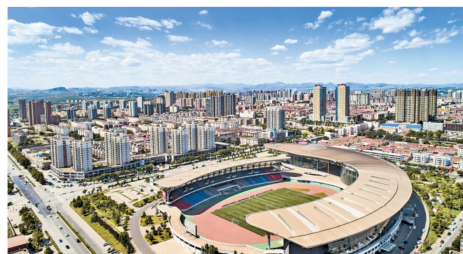
完善城市功能，提升城市品位，武安加快建设现代化中等城市。图为武安城区一角。武安市委宣传部供图
