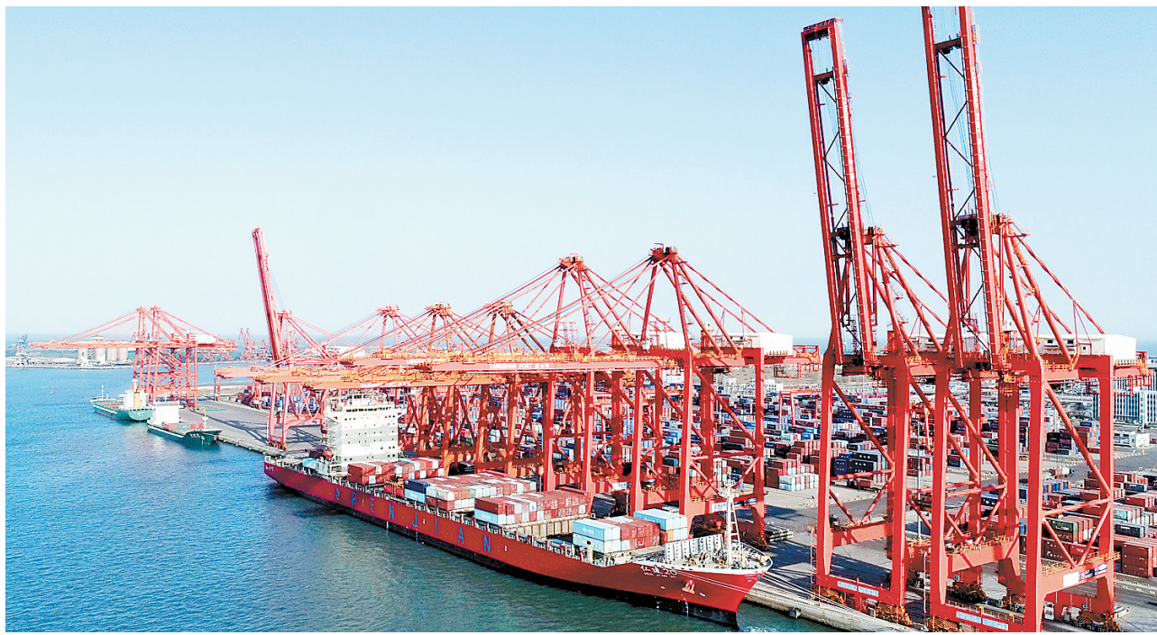
4月8日,一艘轮船靠泊在唐山港京唐港区集装箱码头装货(无人机照片)。
