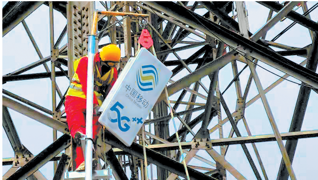
4月6日,在邢台市平乡县河古庙镇,邢台移动工程建设人员正在紧张进行5G射频模块吊坠工作。 邢台移动供图
