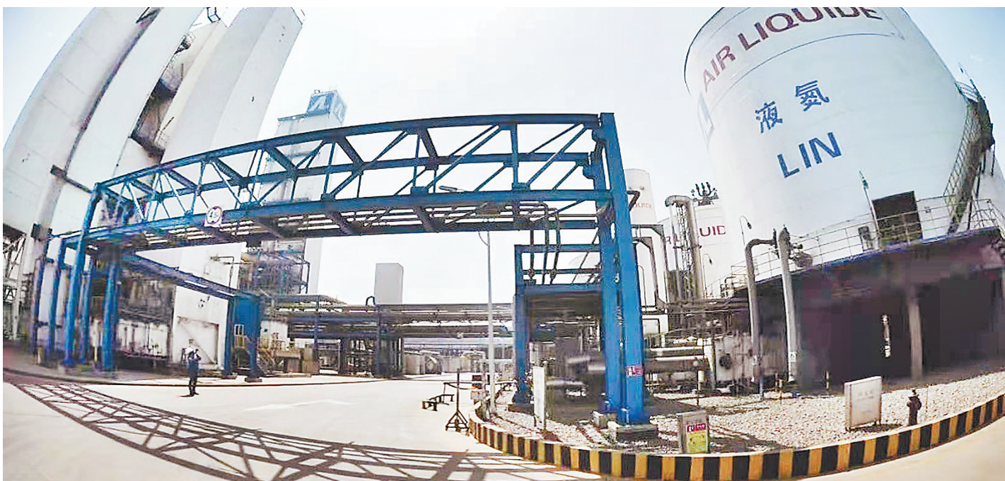
沧州渤海新区以技术改造引领石油化工等主导产业升级,为实现高质量跨越式发展注入强劲动力。这是法液空项目技改现场。渤海新区供图
