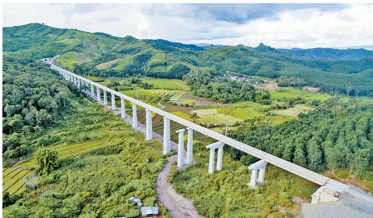
这是2020年7月29日在老挝北部拍摄的建设中的中老铁路。
