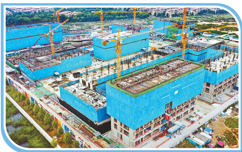
实施园区双倍增计划，全力提升北中南三大板块发展水平。图为大厂高新区内的数字经济总部商务区项目。
