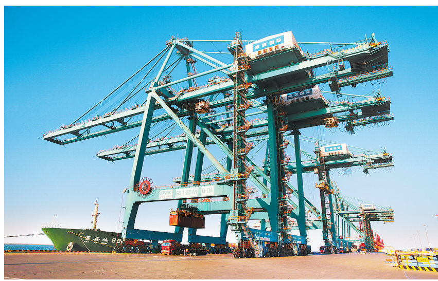
今年,渤海新区将突出抓好港口龙头,在提升港口通过能力、集装箱吞吐能力和吸引集聚能力上重点突破。这是黄骅港集装箱码头。 河北日报通讯员 苑立伟摄
