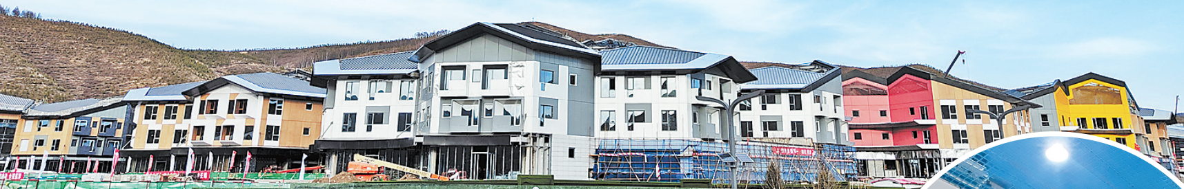
4月18日,蓝天白云下的崇礼太子城冰雪小镇。作为北京2022年冬奥会和冬残奥会张家口赛区重点配套工程,该项目主体结构已全部完工,正在加快建设内部装饰工程。河北日报记者 赵海江摄
