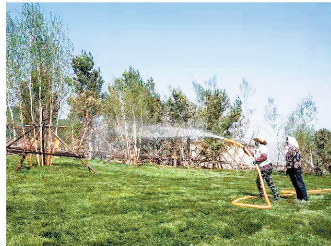
连日来,崇礼区冬奥核心区绿化景观提升工程施工人员为打造冬奥会赛事景观风貌全力以赴。从今年3月开始,崇礼区全面启动冬奥核心区绿化景观提升工程,绿化面积近1900亩,将按照“全域、全景、全要素”的原则,形成冬奥核心区完整的生态绿地体系。
