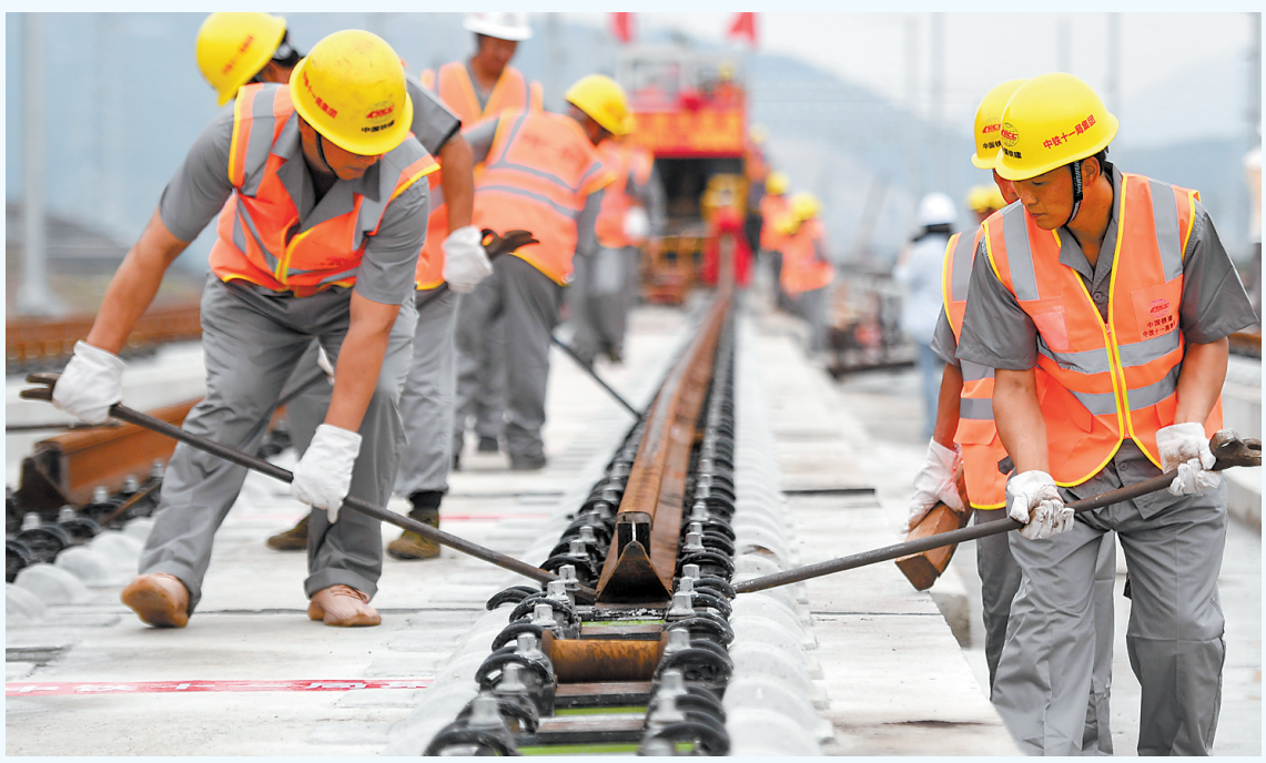
6月22日，中铁十一局的施工人员在杭绍台铁路上进行铺轨作业。当日，在杭绍台铁路温岭站施工现场，随着最后一根钢轨平稳在无缝道床上铺设到位，我国首条民营控股高铁杭绍台铁路全线铺轨贯通，为年底开通运营奠定基础。杭绍台铁路连接浙江杭州、绍兴和台州三地，线路设计时速350公里。新华社记者 黄宗治摄
