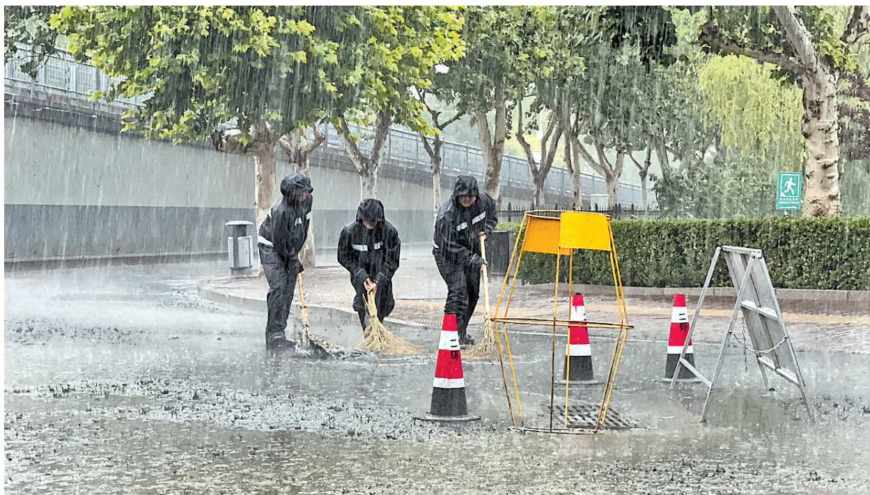
7月11日,石家庄市裕华区城管局工作人员在裕华路与东二环桥下冒雨清理积水。
