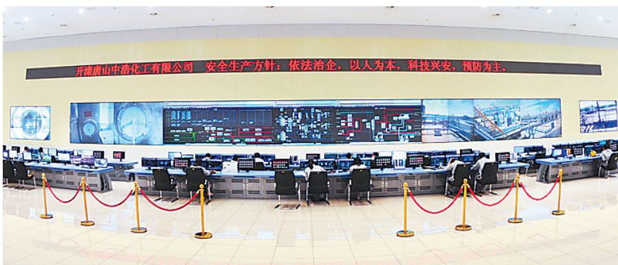
中浩化工有限公司集中控制中心。
