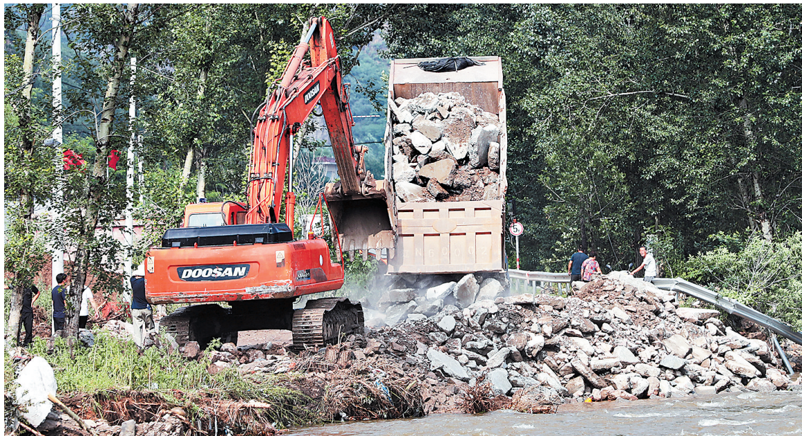
7月15日,承德县交通部门在承德县鞍匠镇大甸子村东抢修损毁道路。7月12日至13日,承德县白河上游普降大暴雨,白河断面洪峰流量903立方米/秒,发生了超10年一遇的洪水。洪灾发生后,该县交通、电力、通讯等多个部门全面启动应急预案,迅速行动,全力投入到抗洪抢险工作中。
