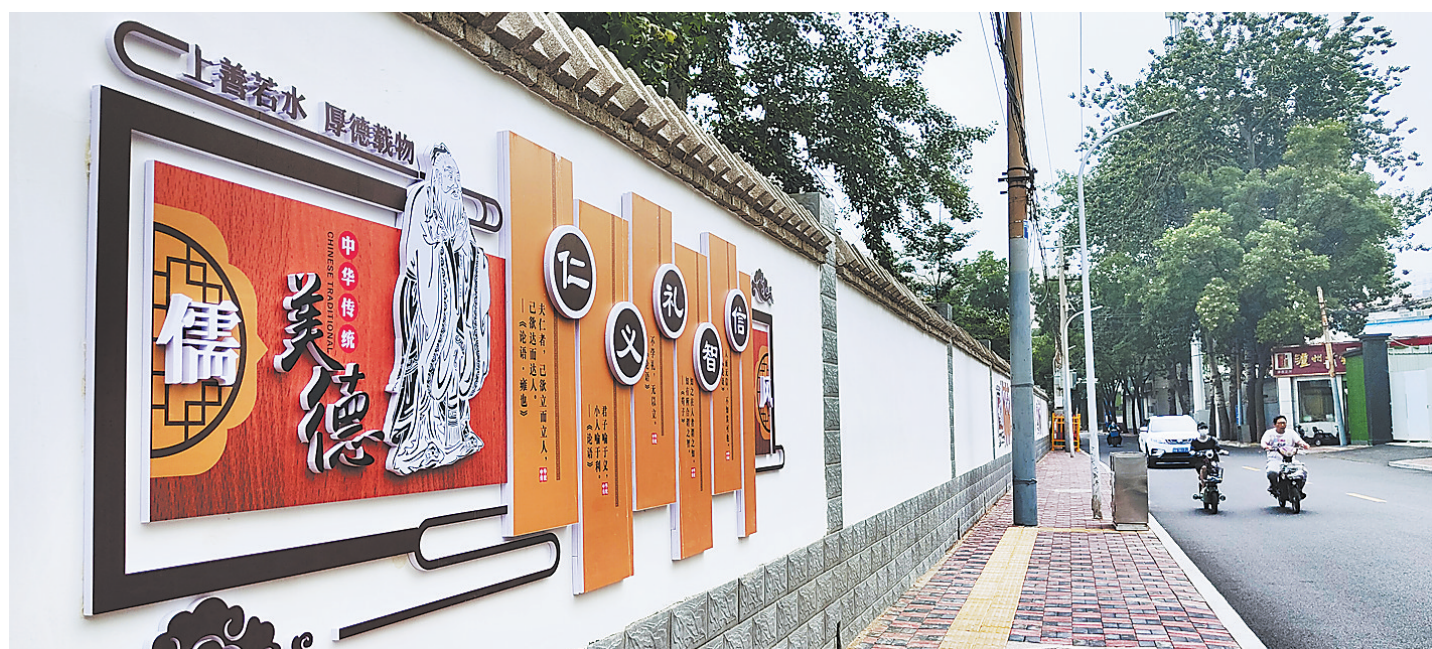
近日,整治提升后的石家庄市支农路让人耳目一新。路面干净整洁,传统文化墙设计精美。
