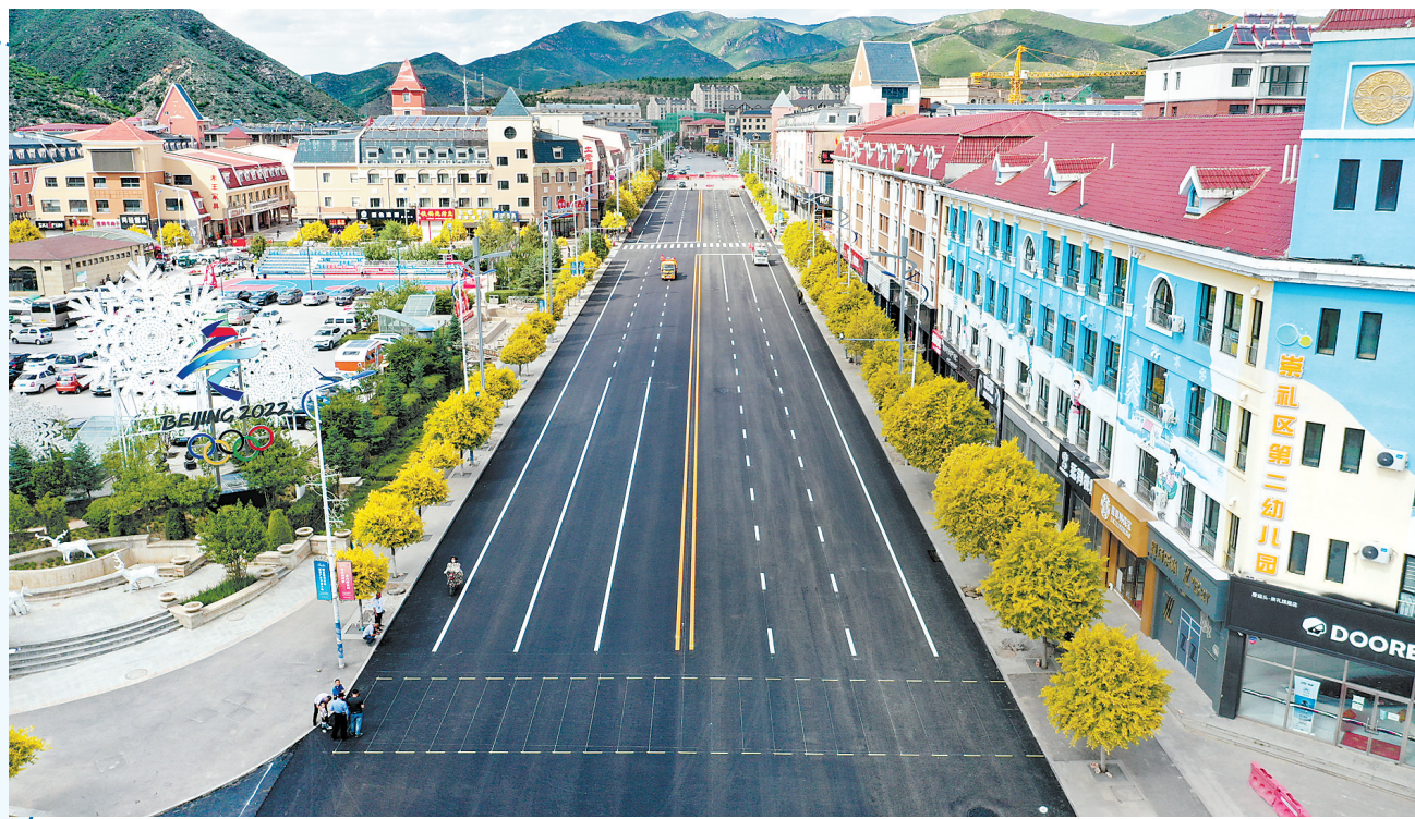
7月15日,无人机拍摄的崇礼主城区,近日改造完成的裕兴路宽阔平整。
