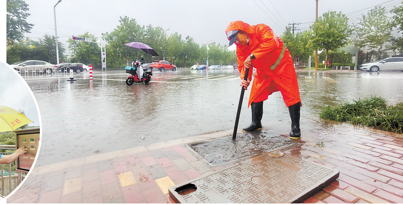
▲7月21日,邢台市环卫公司环卫工人在市区街头排水。
