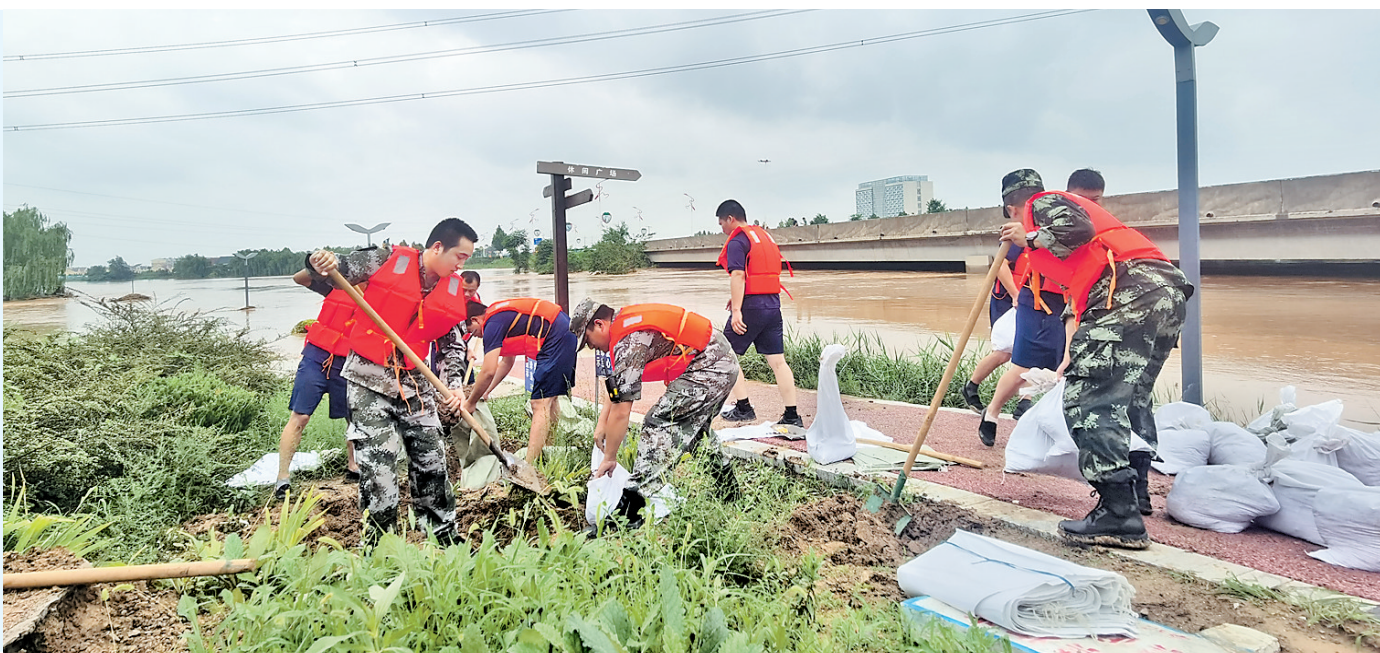
7月22日上午,邢台市中兴大街衡水河大桥附近,抢险人员在装填沙袋,加固河堤。 河北日报记者 邢云摄
