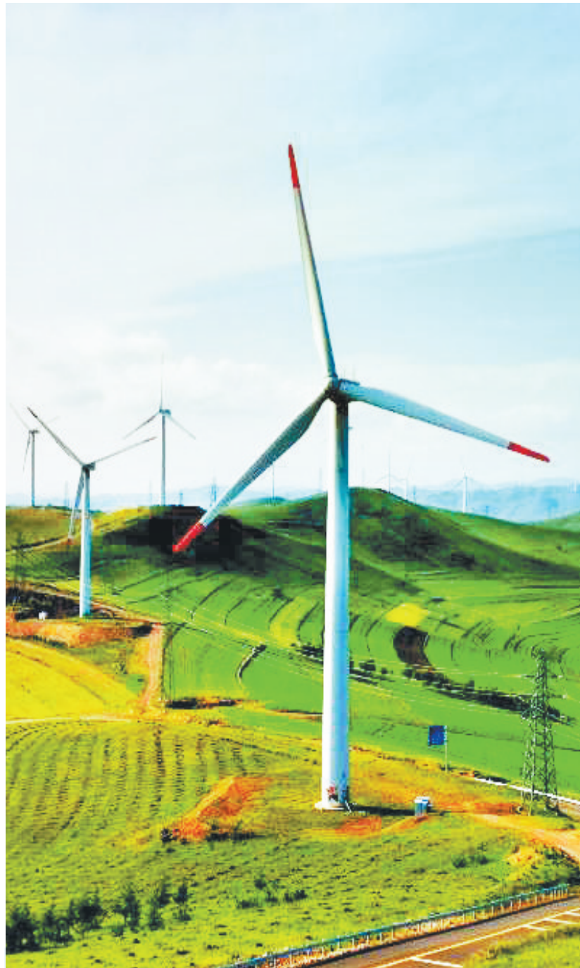
▲沽源草原天路沿线风电场。 河北日报通讯员 梁志刚摄 ▶沽源滦河神韵景区的壮丽景观。 河北日报通讯员 梁志刚摄
