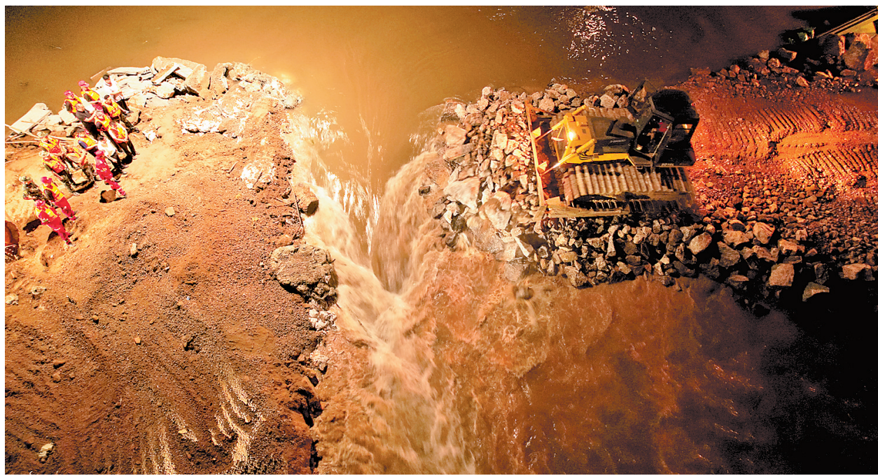
这是7月26日拍摄的卫河鹤壁市浚县新镇镇彭村决口封堵现场(无人机照片)。 新华社发(张小明摄)
