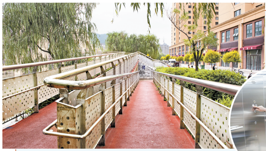
▲崇礼区滨河公园的无障碍设施。崇礼区无障碍环境建设工作领导小组办公室供图
