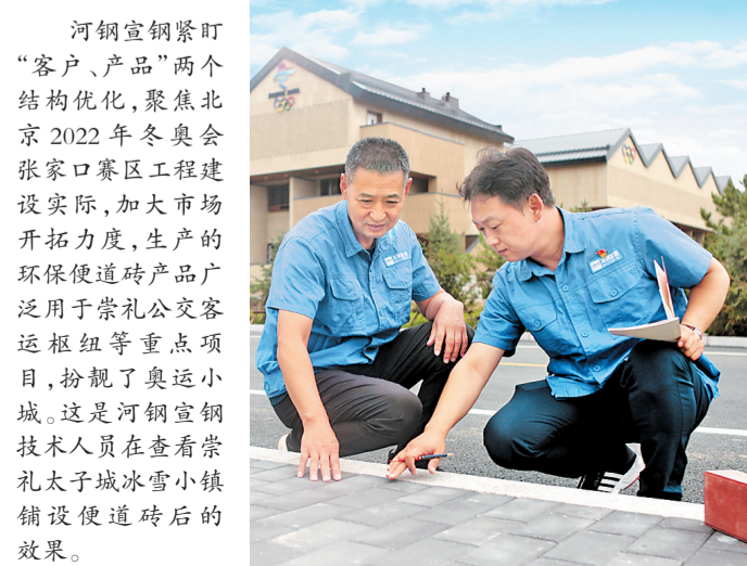
河钢宣钢紧盯“客户、产品”两个结构优化,聚焦北京2022年冬奥会张家口赛区工程建设实际,加大市场开拓力度,生产的环保道砖产品广泛用于崇礼公交客运枢纽等重点项目,扮靓了奥运小城。这是河钢宣钢技术人员在查看崇礼太子城冰雪小镇铺设道砖后的效果。
