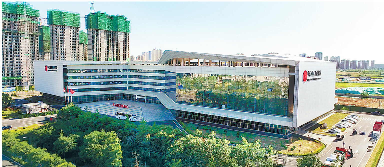
近期拍摄的中信重工开诚特种机器人研发及产业化基地项目一期。目前,该项目一期已建成投用,建成了特种机器人研制、远程控制、培训体验、检测、展示及综合服务五大中心,成为国内最大的特种机器人研发制造基地。
