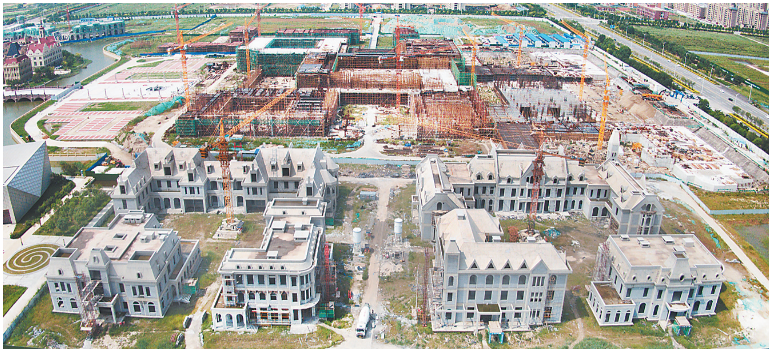
▲中东欧商务中心项目建设现场。
