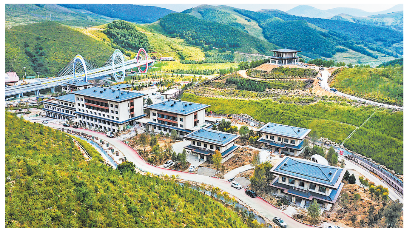
8月31日,延崇高速太子城和平驿站建设基本完工。延崇高速太子城和平驿站位于张家口市崇礼区延崇高速太子城互通出口处,是河北省首座高速公路线外开放式生态智慧服务区。河北日报记者 耿 辉摄
