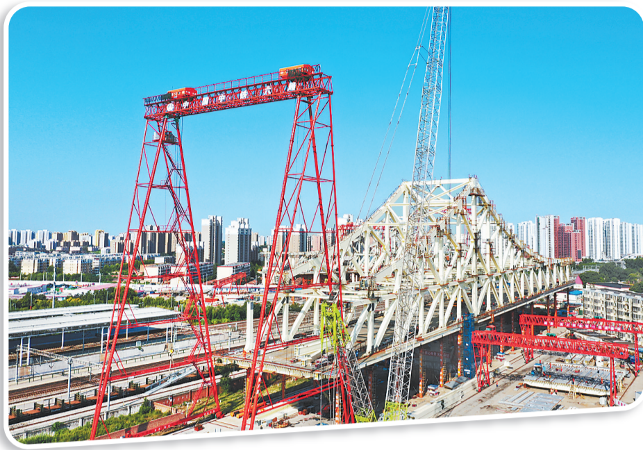
廊坊市交通中心工程上跨铁路的主桥段施工现场,工人们正加紧拼装钢桁梁结构。 河北日报通讯员 贾 珺摄
