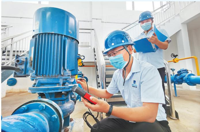
日前,在北控(武强)水务有限公司农水泵站,工作人员对输水管道运行震动值进行测量。
