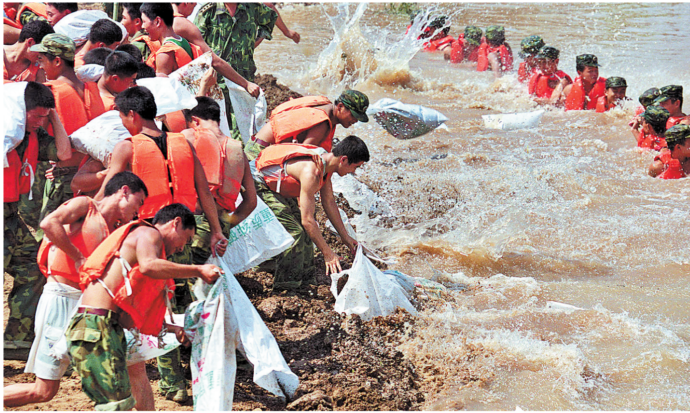
湖北石首久合垸乡团山河支堤出现“管涌”险情,解放军官兵以血肉之躯挡住肆虐的洪水,同时加固堤防(资料片)。
