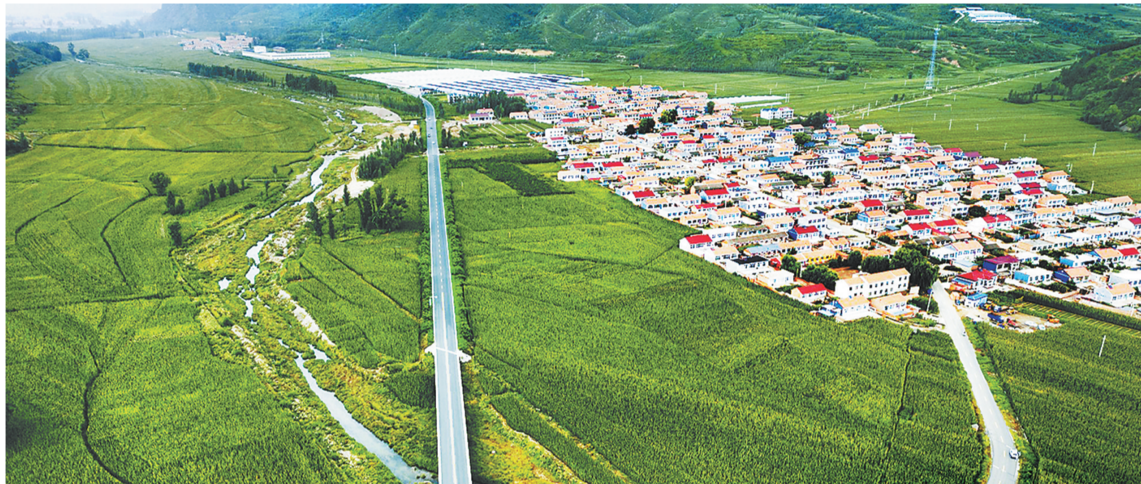
从县城到山区、从主干公路到偏远村组，一条条“四好农村路”延伸到百姓家门口，助力隆化县乡村振兴。这是隆化乡村的公路。河北日报通讯员 孙成龙摄
