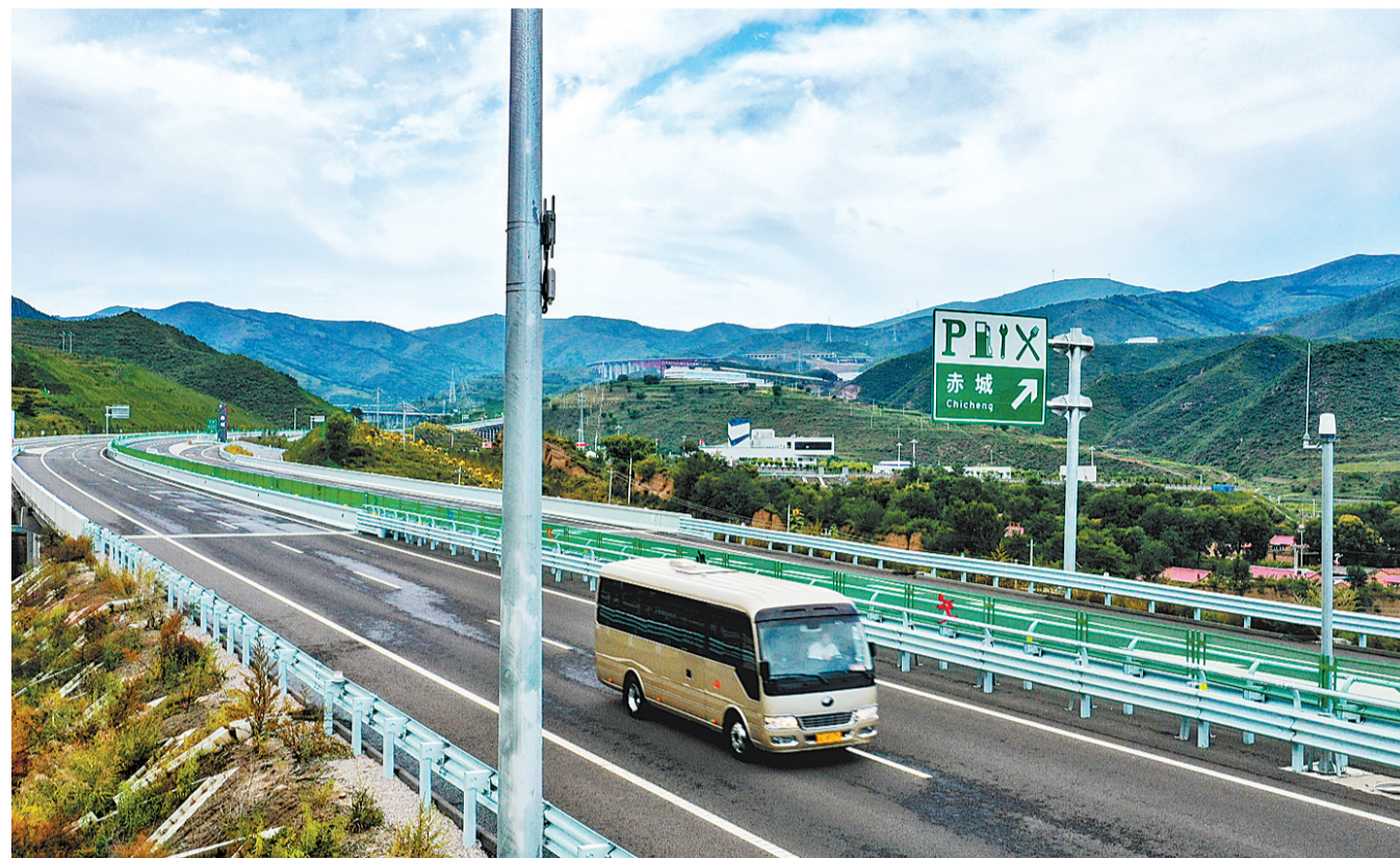
延崇高速主路段两侧的路杆上已经安装了测速雷达和RSU(路侧单元)。
