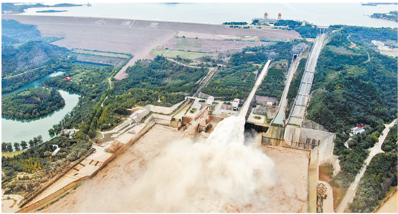
2021年10月12日拍摄的黄河小浪底水库泄洪场景(无人机照片)。
