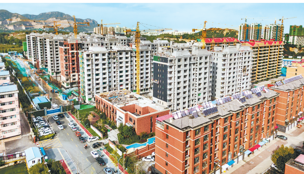
近日航拍的石家庄市鹿泉区中村改造项目。今年以来,鹿泉区加大城市更新力度,谋划县域建设项目45项,大力开展城中村改造、园林绿化建设等工作,全力打造宜居宜业新城。河北日报记者 赵杰摄
