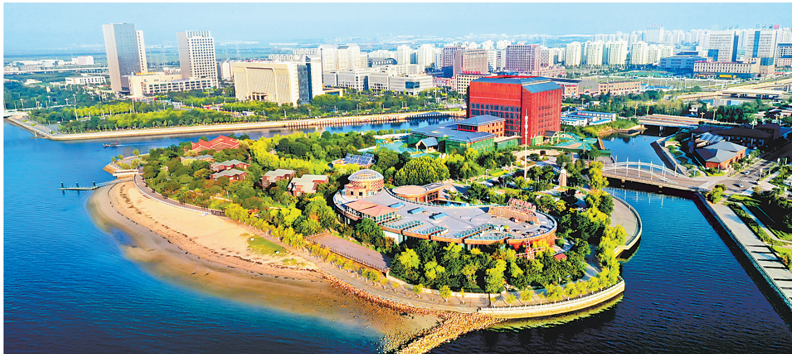
▲随着城市建设不断完善,城市经济持续发展,曹妃甸这座滨海城市魅力无限。 ▶日前,在唐山曹妃甸港区矿石码头,货轮在拖轮协助下进行靠泊作业。
