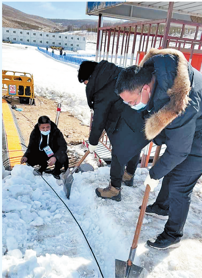
图为国家越野滑雪中心通信保障团队的工作人员正在施工。 河北联通供图
