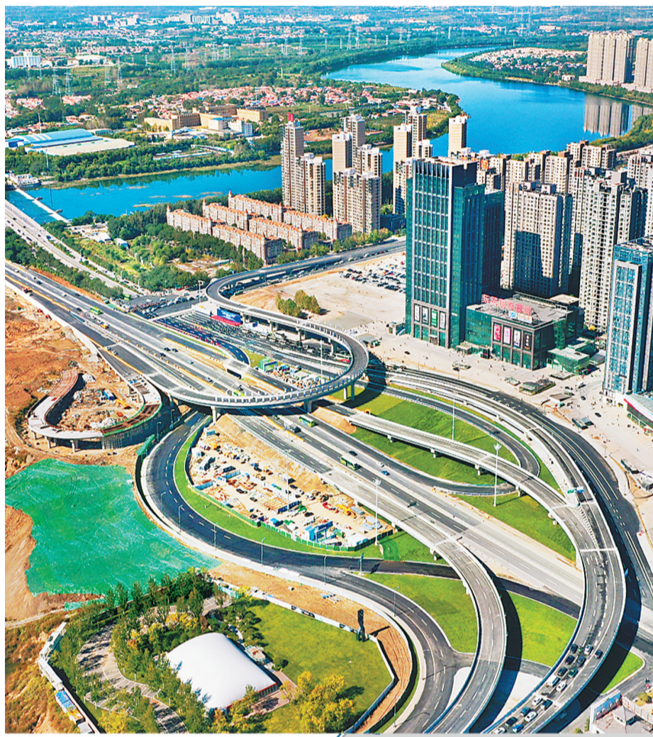
▲近日,通燕高速燕郊出口立交枢纽正式通车。
