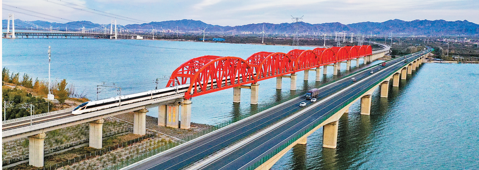
列车驶过张家口怀来县京张高铁官厅水库特大桥。(本报资料片) 河北日报记者 耿辉摄
